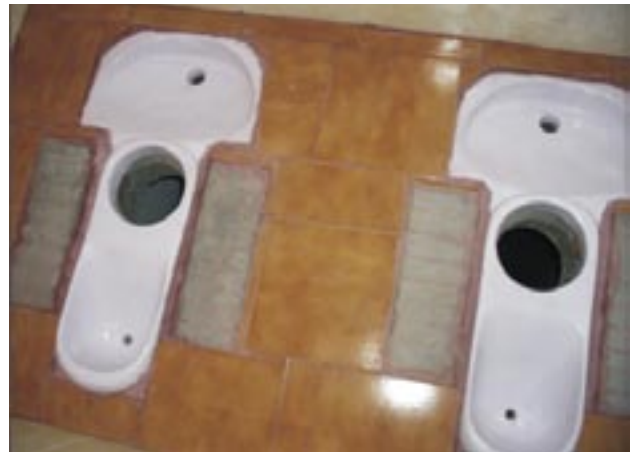
Inside Ecosan Toilet
